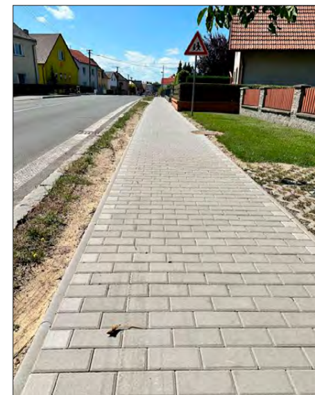
1. etapa chodníku v Zábřehu
