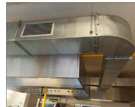
Výměna vzduchotechniky v mateřské školce
