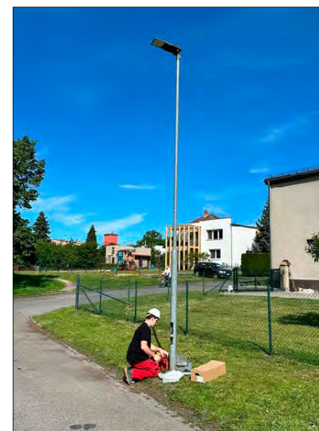
Výměna veřejného osvětlení
