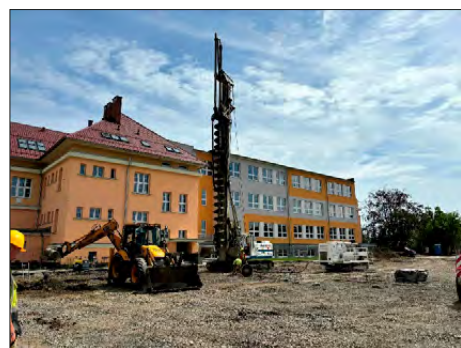
Výstavba tělocvičny Základní školy
