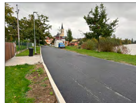
Rekonstrukce povrchu na ulici Podubí
